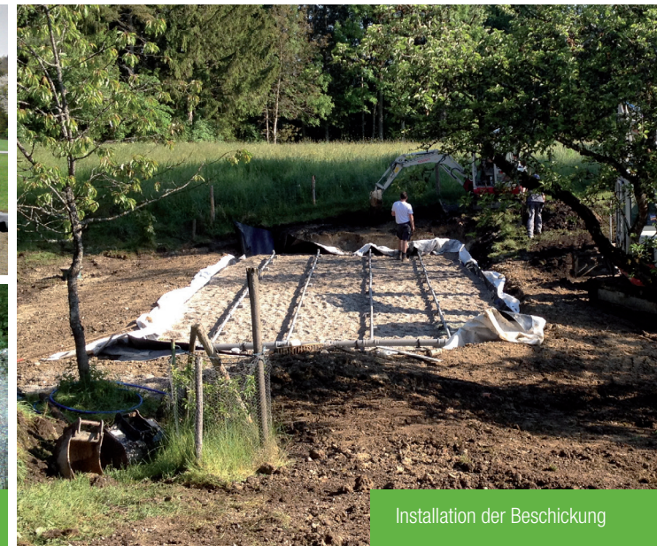
Einbringen des Filtermaterials
