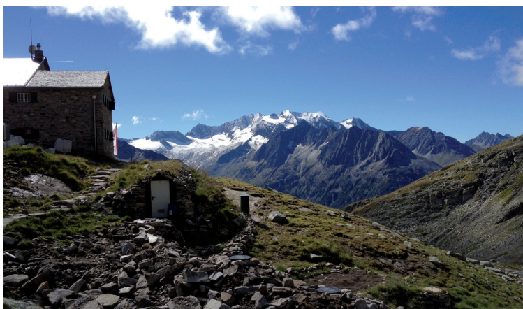
Friesenberghaus, 2498 m, Neubau der Kläranlage für 93 EW
