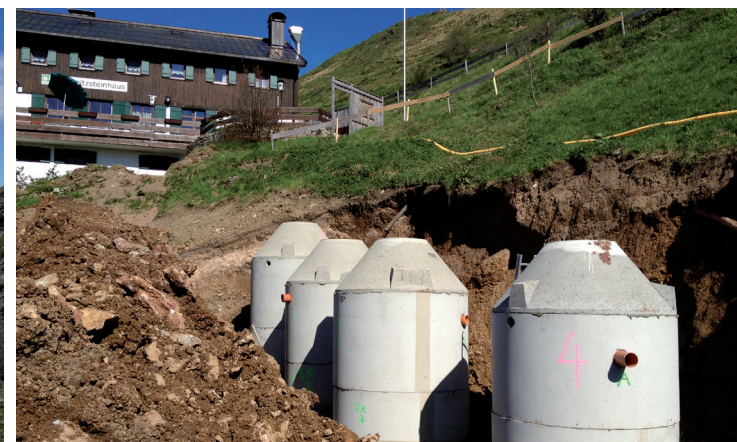
Spitzsteinhaus, 1252 m, Neubau der Kläranlage für 60 EW
