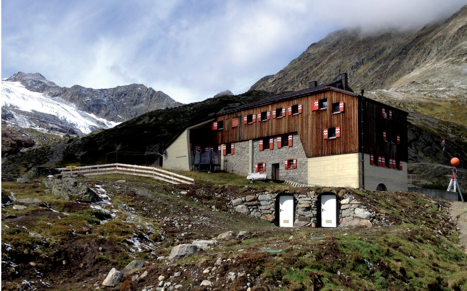
Sulzenauhütte, 2191 m, Neubau der Kläranlage für 150 EW
